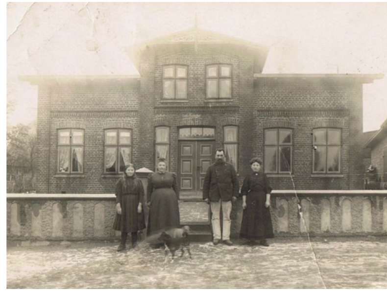
Eine Postkarte, abgestempelt am 14. August 1922, zeigt den Urzustand des Hauses
