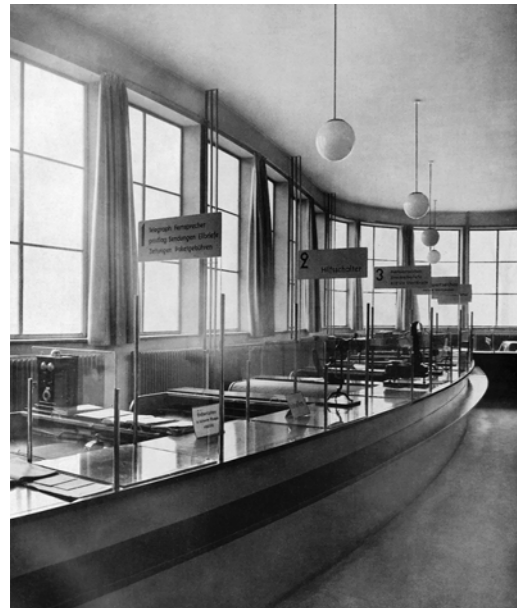
Schalterhalle des Postamts Goetheplatz in München, um 1932. Entwurf: Walther Schmidt, Franz Holzhammer.
