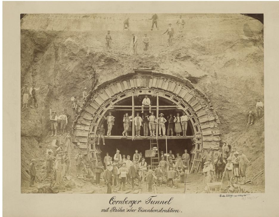
**Bau der Bebra-Göttinger Eisenbahn: „Cornberger Tunnel mit Rziha'scher Eisenkonstruktion“.** Mit der von ihm entwickelten Methode, das Erdreich nicht wie bislang mit einem Holzgerüst, sondern mit einer Eisenkonstruktion abzustützen, wurde der Bergbautechniker Franz von Rziha weltweit bekannt.
