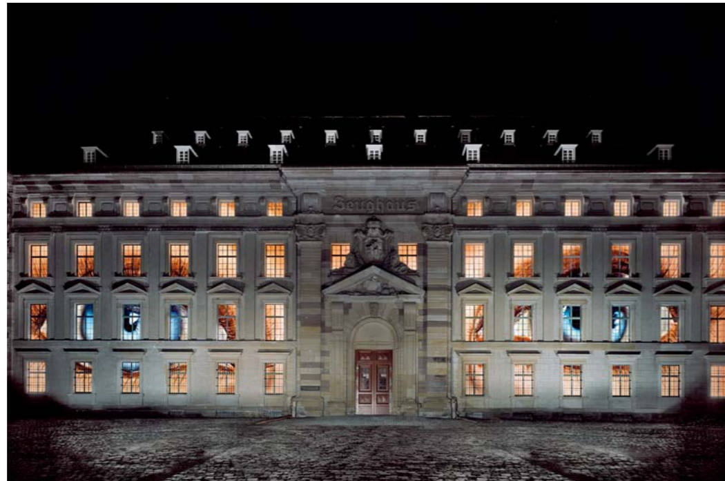
Nach der Sanierung durch Pfeiffer Ellermann Preckel, Berlin, eröffnet das Mannheimer Zeughaus für die kulturhistorischen Sammlungen der Reiss-Engelhorn-Museen mit einer Lichtinstallation von Elisabeth Brockmann.
