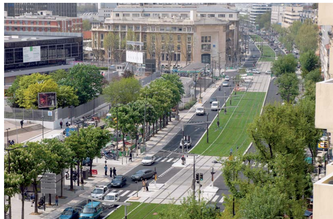
Der Bau der neuen Tramlinie auf dem Boulevartring les Maréchaux wurde dazu genutzt, den Straßenraum völlig neu zu gestalten. Oben: die Place de la Porte de Versailles . Fotos: Marc Verhille/Mairie de Paris; Jean-François Mauboussin/RATP
