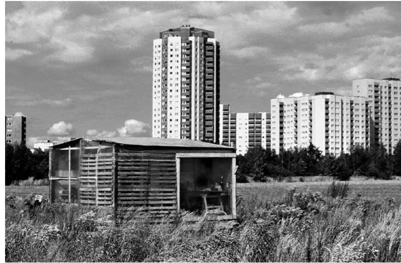
Eine Woche lang lebten die Berliner Künstler Folke Köbberling und Martin Kaltwasser auf einer Wiese vor den Toren der Berliner Gropiusstadt in einer nach Art der Gecekondu gebauten Hütte aus altem Baumaterial. Gecekondu bedeutet im Türkischen „über Nacht gebaut“. Das osmanische Recht besagt, dass ein neu gebautes Haus, sobald es ein Dach hat, nicht mehr abgerissen werden darf.
