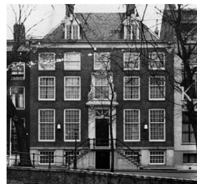
Das Haus Kaisersgracht 556 vor (oben) und nach der Restaurierung durch A. A. Kok. Fotos: NAI
