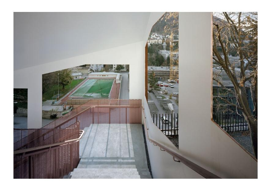
Durch die großen Öffnungen und die weiße Farbe im Inneren verliert die Stahlstruktur ihre Schwere. Dass die Decke aus konstruktiven Gründen zweischichtig aufgebaut ist, bleibt verborgen. Dies gab den Architekten auch die Möglichkeit, die Raumhöhe im Inneren zu variieren.
