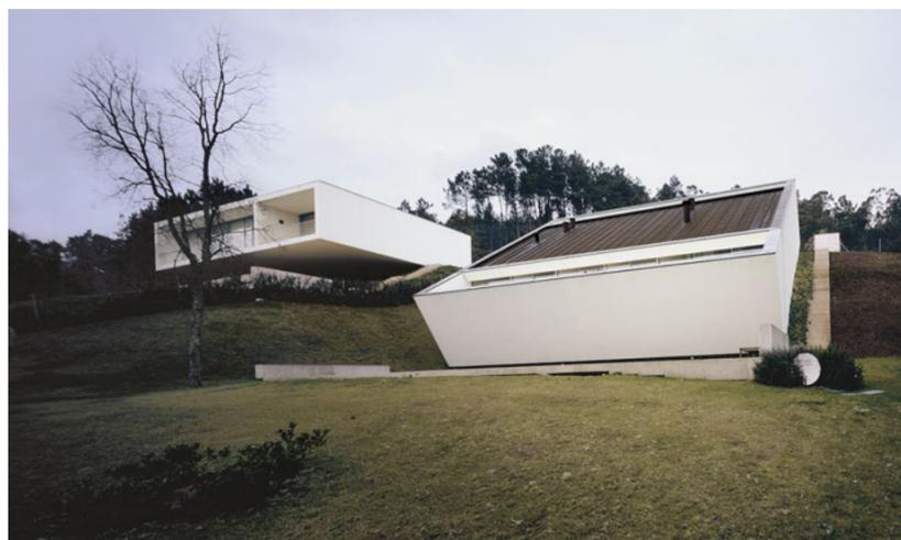
Ein stark geneigtes Grundstück war Ausgangspunkt für den Bau zweier Einfamilienhäuser. Für den Entwurf des einen Hauses (siehe Modellfoto auf dem Titel) orientierte sich der Architekt am Prinzip des Kragarms eines Flaschenhalters. Der extrovertierte Bau erhebt sich über die Landschaft, während sich sein südliches Pendant innerhalb eines fensterlosen Rahmens von der Landschaft abkehrt.
