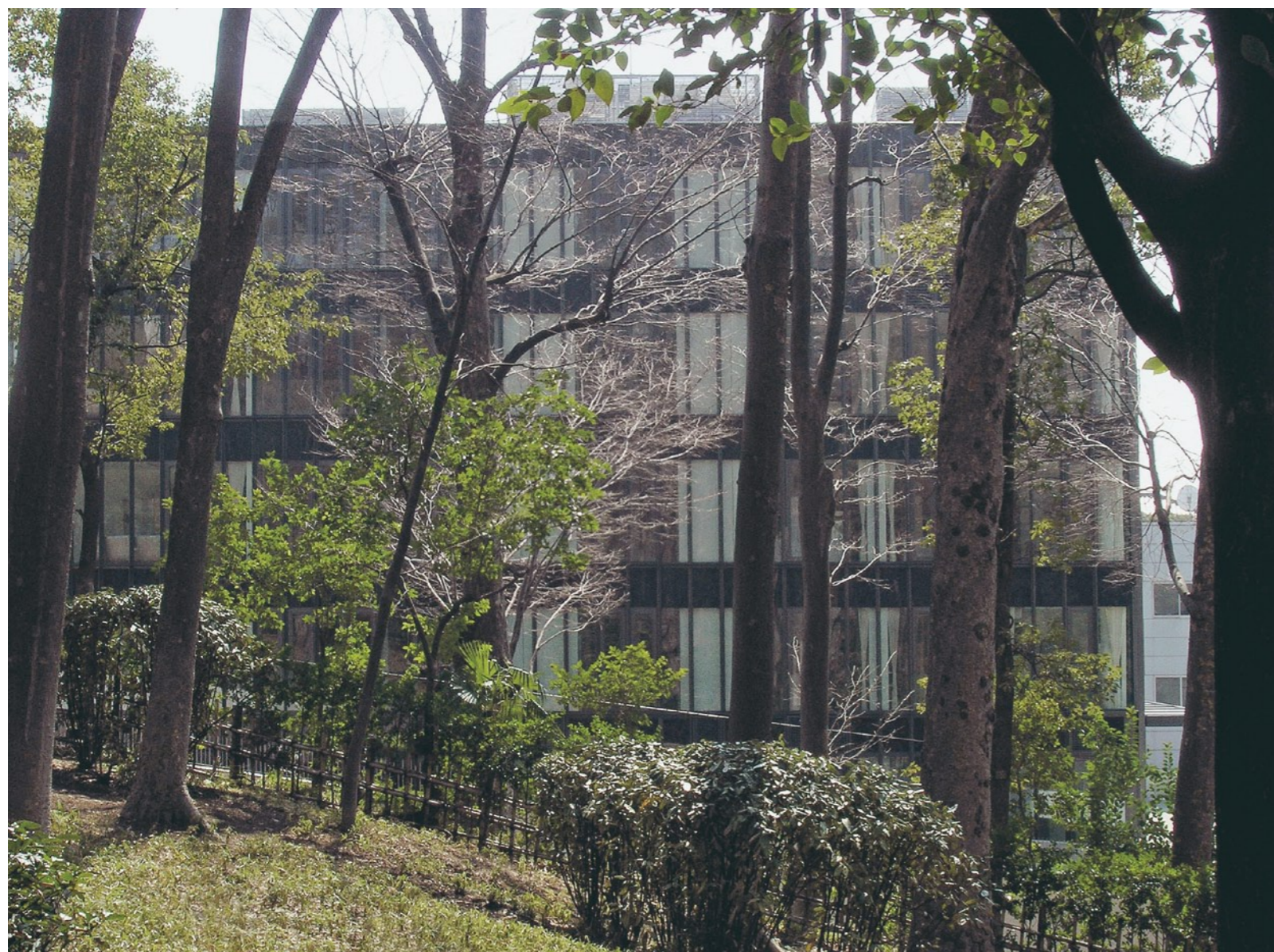
Der Besucher erreicht von der Straße kommend über eine Freitreppe den Vorplatz der Kanzlei. Zwei Eingänge führen ins Gebäude. Rechts – unter dem Adler – der Zugang ins Atrium, links der in den Raum der Visa-Stelle. Nach Süden und Osten blicken die Mitarbeiter in die japanische Gartenlandschaft mit ihrem dichten Baumbestand.
