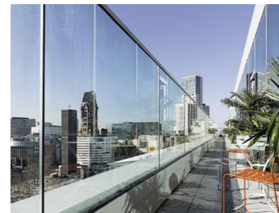
Die Bar und das Restaurant verfügen über gut abgesicherte Terrassen. Auf der Südseite ist sie sehr schmal ausgefallen.
