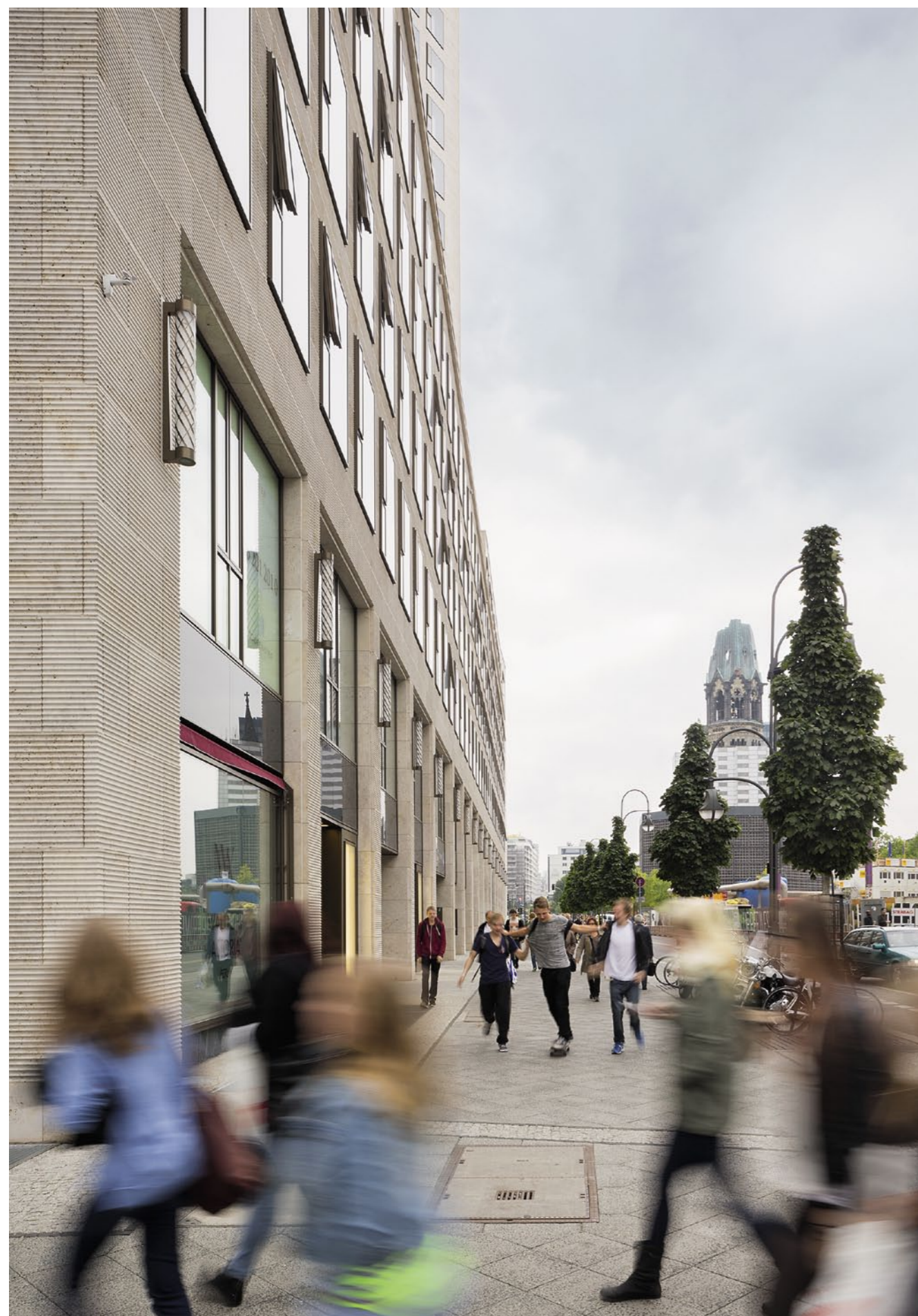
Dort, wo früher das Schimmelpfeng-Haus die Kantstraße überbrückte, hat man heute den freien Blick auf den Breitscheidplatz. Links das Hotel Waldorf Astoria mit Läden, Hotel-Nebeneingang und dem neuen „Romanischen Café“
