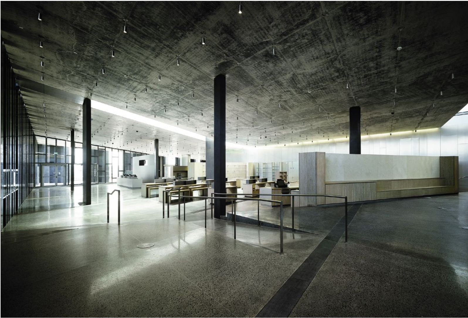
Die Decke aus Sichtbeton wird von Stützen aus zusammengeschweißten Stahltafeln getragen. Da das Besucherzentrum nur ein Geschoss zählt, reichte ein Anstrich, um sie feuerfest zu machen.
