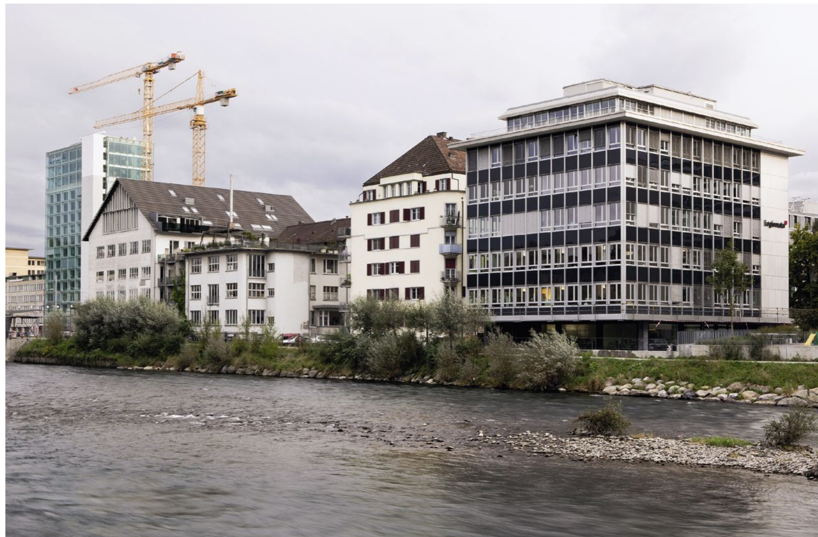
e2a | Hardturmstrasse 76, 8005 Zürich
