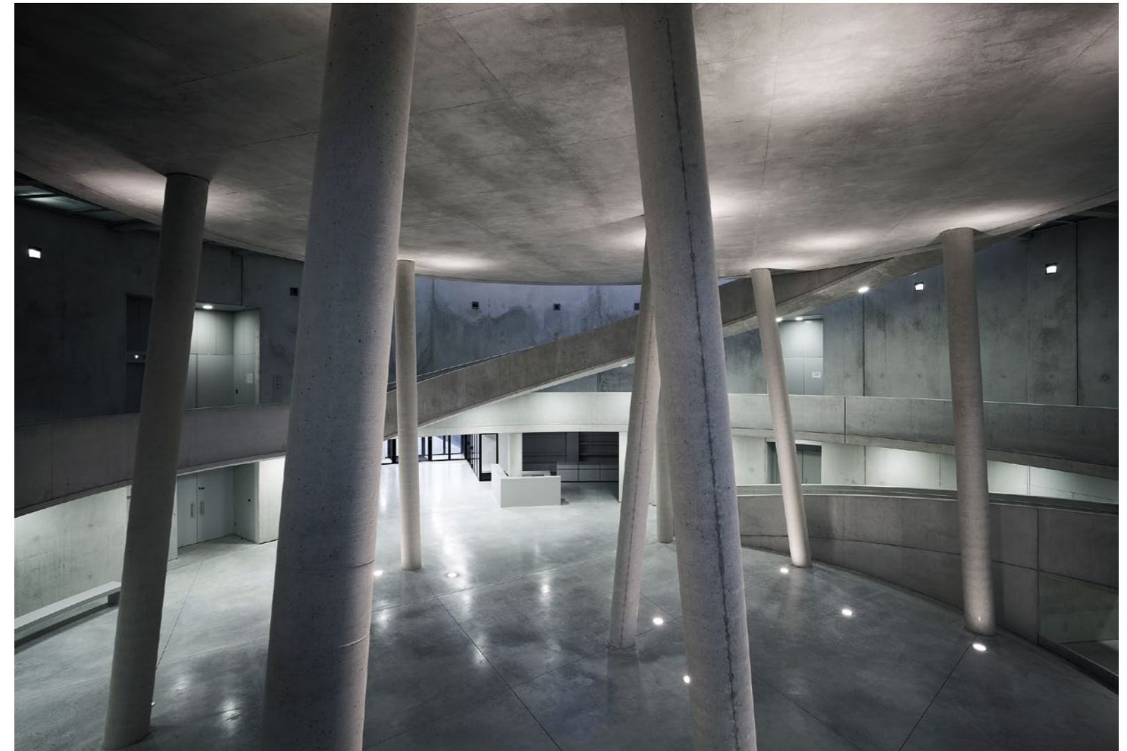
Die zentrale Halle mit den verschiedenen geneigten Rundstützen, die das Auditorium tragen
