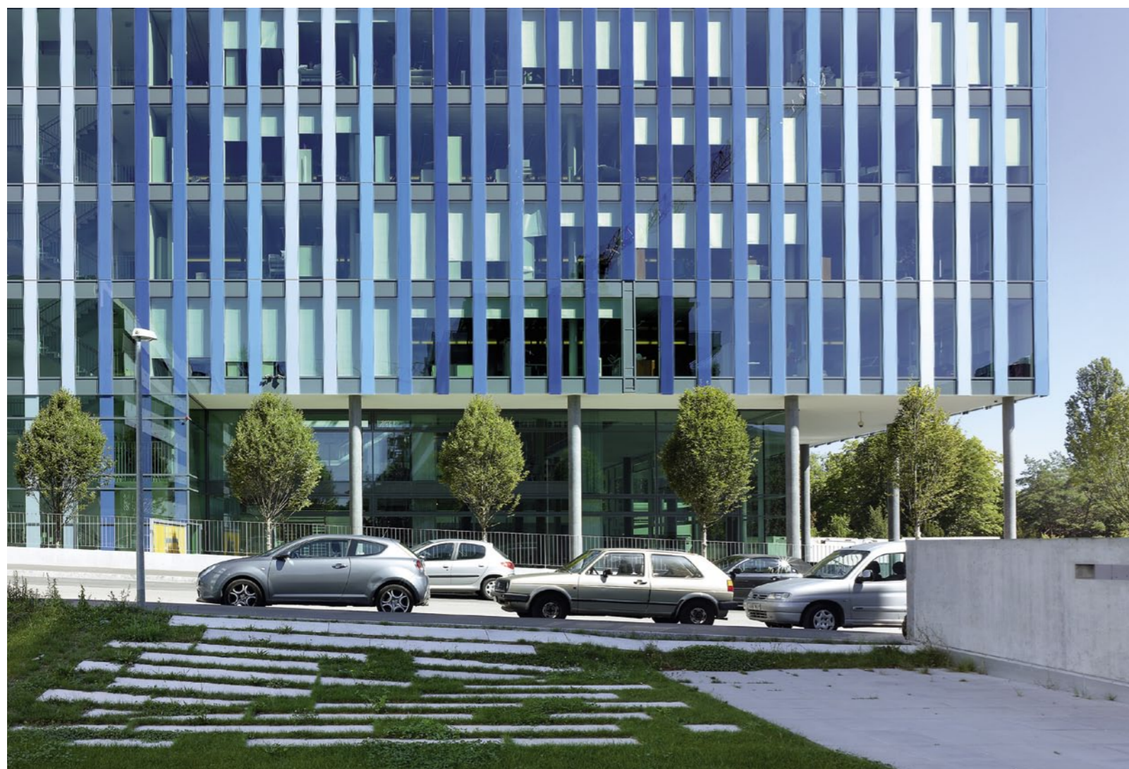
Fassade mit den aufgesetzten farbigen Glaselementen am Chemin du Mont-Soleil
