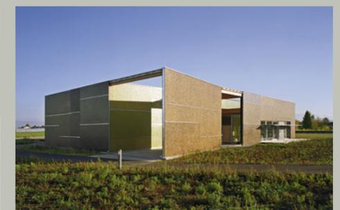
**Die Konstruktion** | Ein Holzskelettbau aus Leimbändern im Abstand von fünf Metern trägt „Isoboxen“ (OSB-Platten beidseitig, dazwischen Mineraldämmwolle) verschiedener Größe: Die Stapelung der 5 x 2,5 Meter und 5 x 1,5 Meter großen Module ist an den Kanten der Traufbleche ablesbar.
