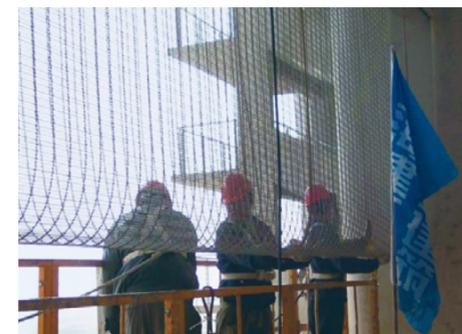
Die Dürener Firma GKD erhielt den Auftrag für die Verkleidung der Haupttribüne mit 13.000 m<sup>2</sup> Metallgewebe. Die 30 m langen Bahnen mussten in wenigen Monaten gewebt, transportiert und montiert werden. Unten: Die Haupttribüne in ganzer Breite mit dem vorgelagerten „Team-Dorf“. Die Piste umgibt ein Grünstreifen.
