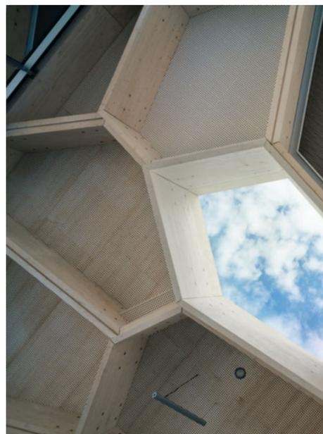
Die weißen Stahlträger der Dachkonstruktion liegen auf neun Stützenbündeln auf; die Holzwanen sind entweder verglast, mit einer künstlichen Beleuchtung ausgestattet oder mit Akustikplatten versehen.
