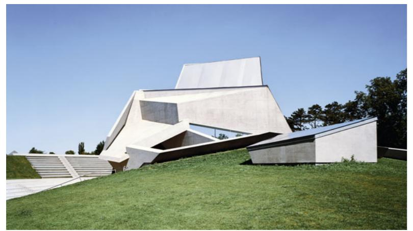
**Auf der Basis aus Beton lagert ein Stahltragwerk. Stahlplatten bilden die Hülle des Turms und sind im Bühnenraum auch über den Beton geklappt.**
