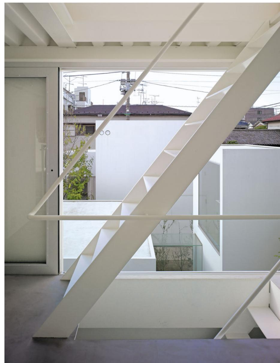
Um auf der bescheidenen Grundstücksgröße eine derartige Vielzahl an Einheiten bauen zu können, wurde auch der Wandaufbau der Wohnboxen knapp gehalten. Die Außenhaut besteht aus 16 mm starken Stahlplatten mit einer minimalen Innendämmung und einer Gipskartonplatte; 8,5 cm misst der Wandaufbau. Die Treppen sind durchweg steil, und die Geländer reduzieren sich auf eine bloße Stange.
