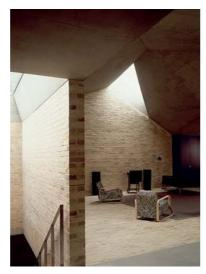
Ein Hauch von Wand, der den Läuferverband auch der Au-Benwände beunruhigend erscheinen lässt. Diese aber sind als Rippenkonstruktion ausgeführt und mithin ausreichend tragfähig.
