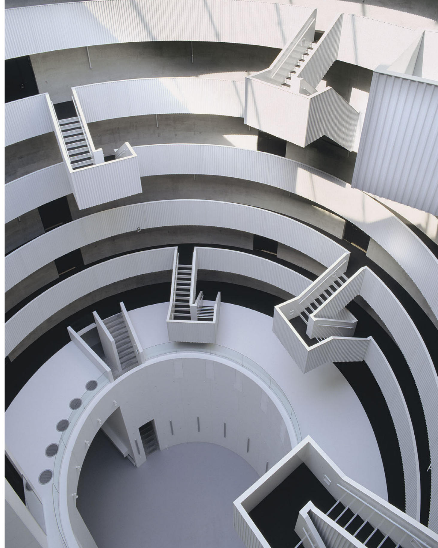
Die auskragenden Treppen bieten gewagte Ausblicke auf das zylinderförmige Atrium. Für die Kommunikation zwischen den Bewohnern sind sie eine Tortur, weil sie von Geschoss zu Geschoss verspringen.
