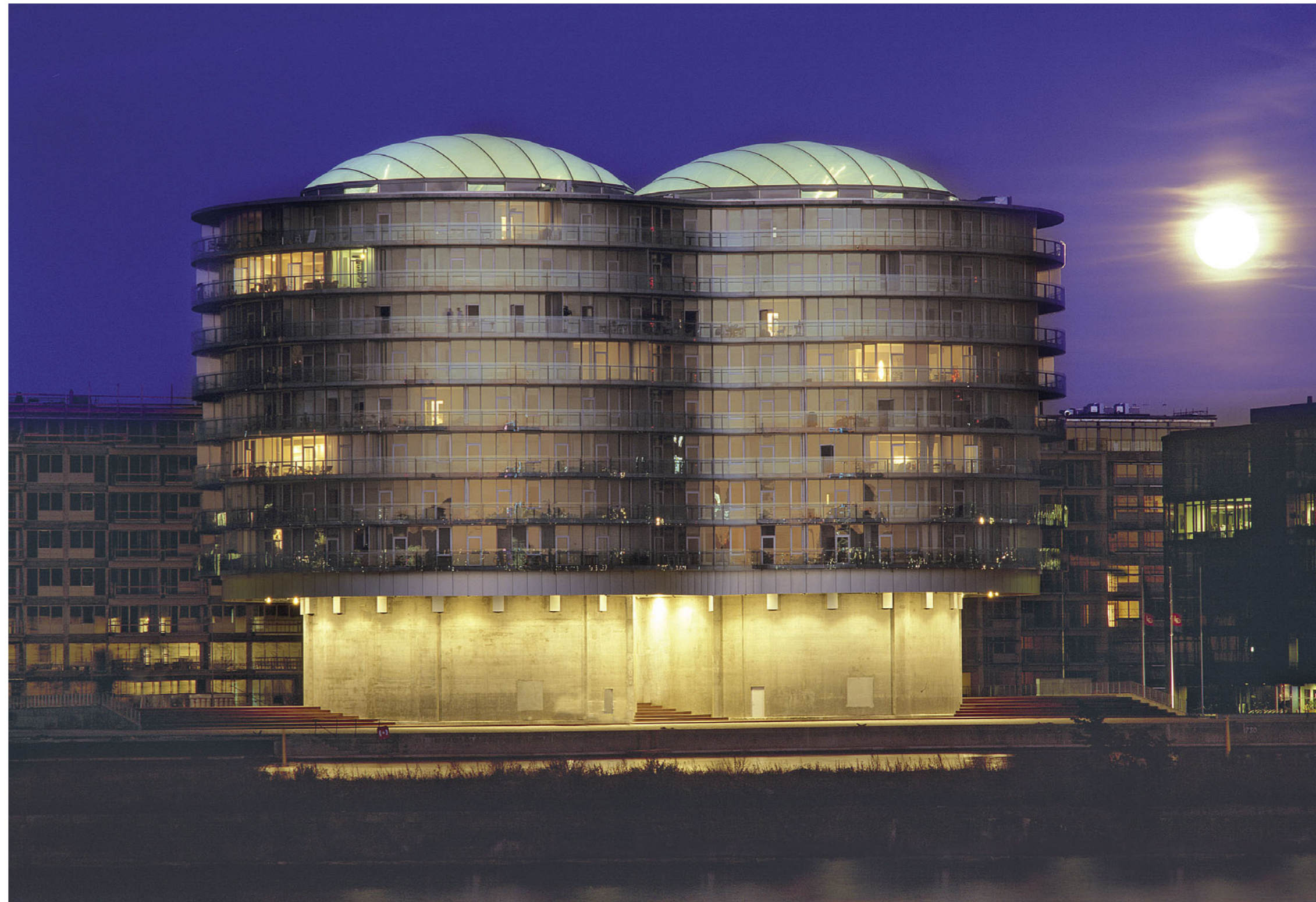
Der rohe Stahlbeton der zehn Meter hohen Sockelzone verweist auf die ursprüngliche Funktion als Futtersilo. Gewohnt wird in acht Kraggeschossen rund um die beiden Zylinder.
