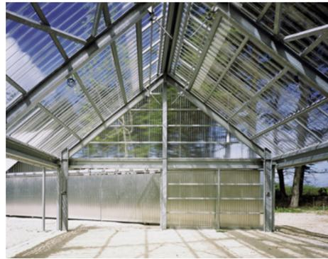
Die dritte Hauseinheit im Osten dient dem Wunsch der Familie, möglichst viel Zeit im Freien zu verbringen; eine mit Polycarbonat verkleidete Stahlkonstruktion überdacht einen Sandplatz. Im Hintergrund sieht man die zur Seite geschobenen Fassaden.
