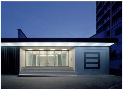
Die Auftraggeber wünschten sich, dass der Charakter einer Hinterhofproduktion zum Verschwinden gebracht werde. Zwei neue Schiebetore und eine Profilglasfassade verdecken den missglückten Umbau aus den achtziger Jahren. Die neue Kaltfassade ist vorgebunden.
