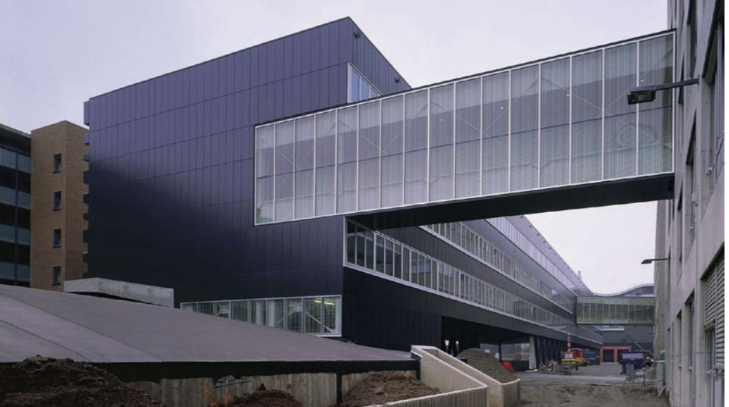
Der aufgeständerte Riegelbau besitzt keinen Eingang, die beiden Brücken zum Altbau wurden entsprechend betont: als wuchtige, einseitig verglaste Blechhülsen. Sie überqueren die Anlieferungszone des Chassé-Theaters und die Einfahrt in die Tiefgarage.
