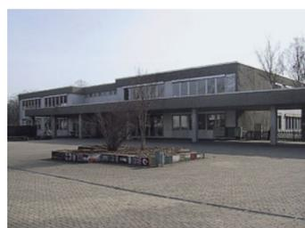
Der Waschbetonbau ist unter einem neuen Kleid versteckt, das Anschluss an den Fünfziger-Jahre-Schulbau sucht und die Verbindung zu der Sporthalle (rechts) abbricht. Der Schulhof erhielt lediglich eine neue Asphaltdecke.
