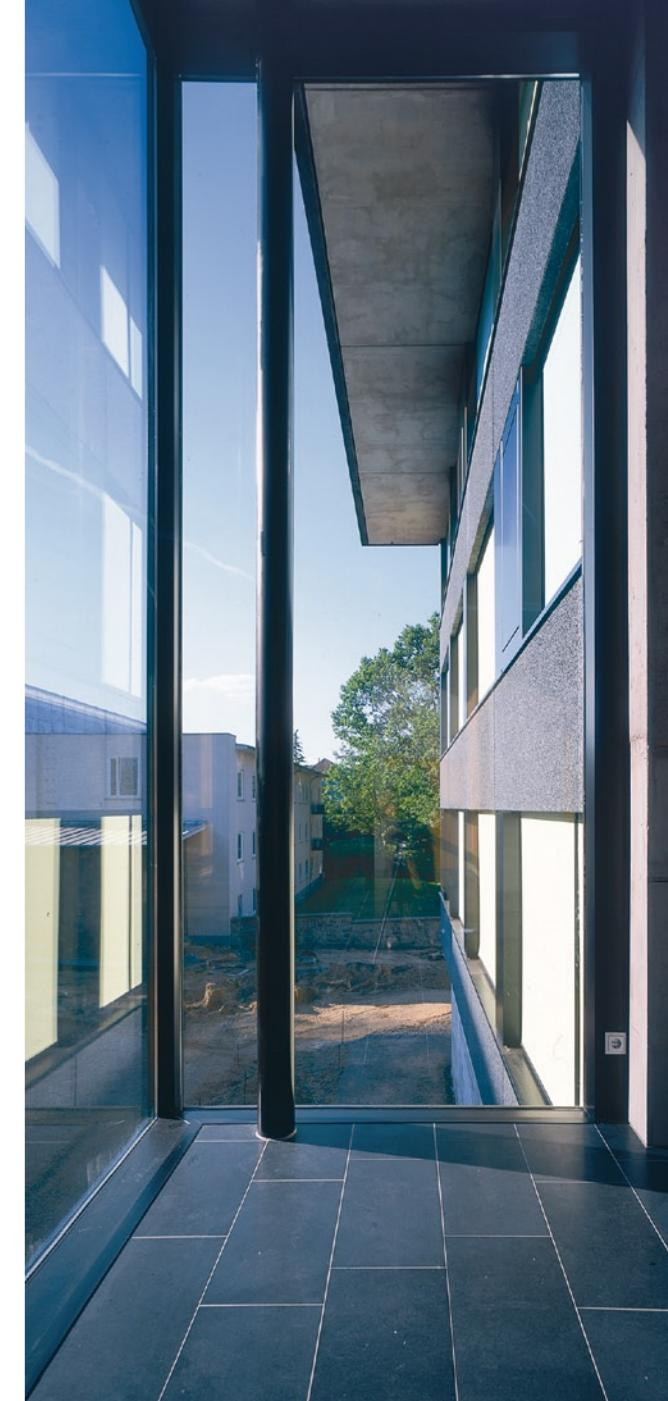
Brüstungsbänder aus durchgefärbten Waschbetontafeln zitieren die zahlreichen Sechziger-Jahre-Bauten der Umgebung, das kontrollierte Verspringen vertikaler Linien ist ein heutiges Gestaltungselement. Der Sockel wurde mit schräg verlaufenden Scheinfugen überzogen.
