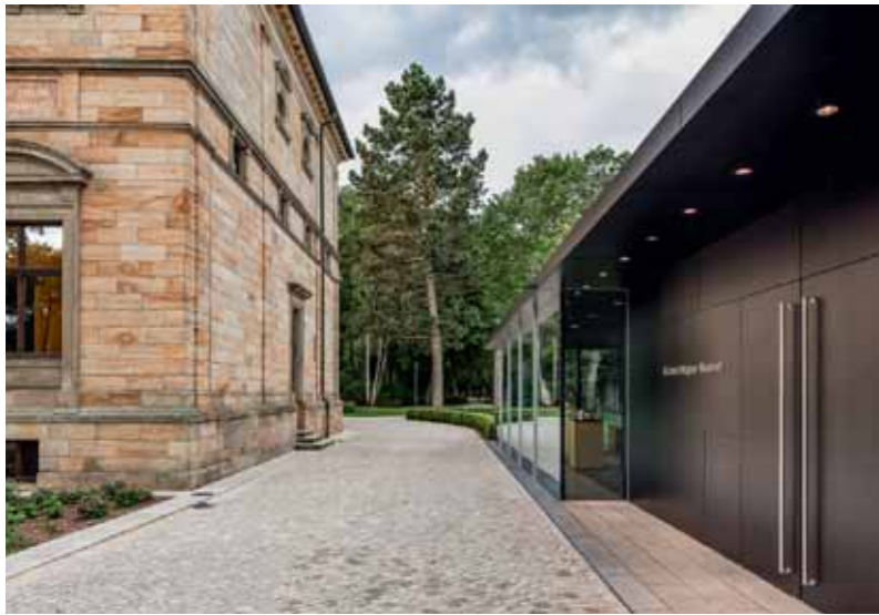
Linkerhand Haus Wahnfried, rechterhand der neue Haupteingang ins Richard-Wagner-Museum im Erweiterungsbau
