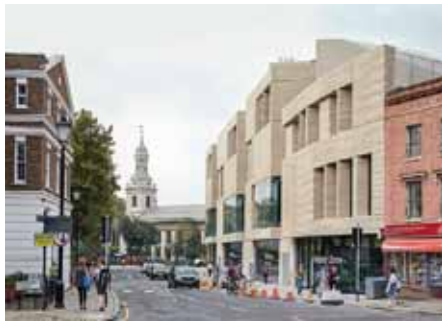
Sich in die kleinteilige Stadtstruktur von Greenwich einpassen, das war die Aufgabe der Fassadengestaltung. Der helle Kalkstein kommt aus Deutschland.
