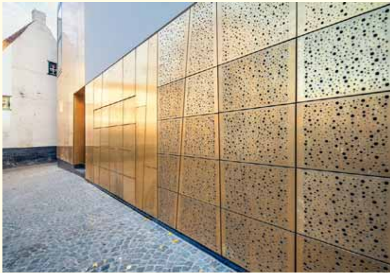
Bei der Renovierung des Stadtpalais De Patria im belgischen Kortrijk verwendeten Adins – Van Looveren Architects TECU® Brass-Verbundelemente Foto: Adins – Van Looveren architects; Zeichnung: KME Osnabrück
